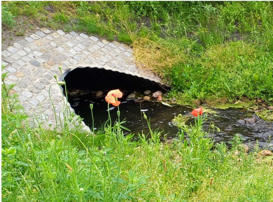
Abbildung 4: Beispielfoto Wellstahldurchlass (Strenkgraben, OPR)
